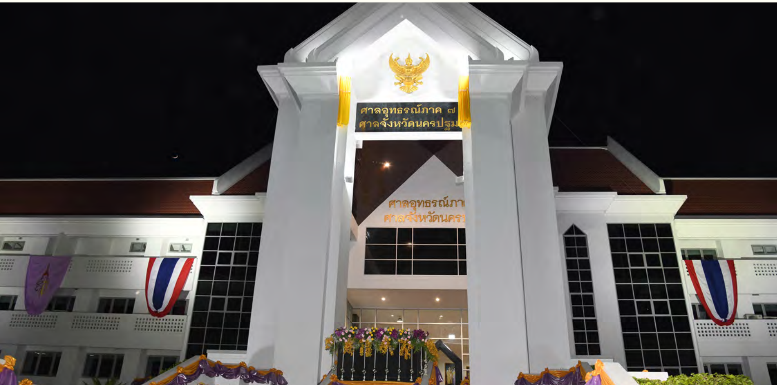
อาคารที่ทำการศาลอุทธรณ์ภาค ๗ และศาลจังหวัดนครปฐม
