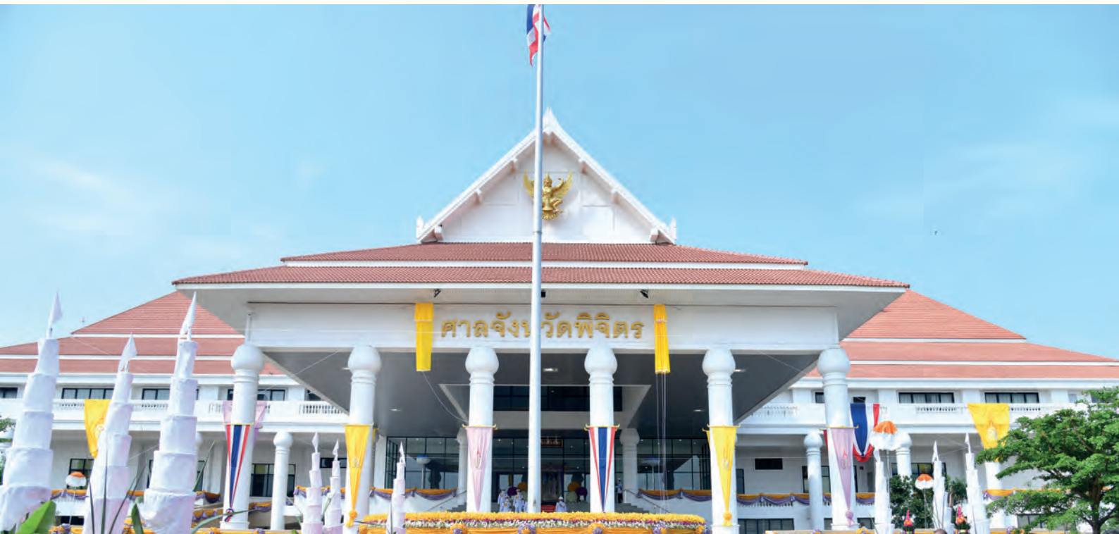
อาคารที่ทำการศาลจังหวัดพิจิตร
