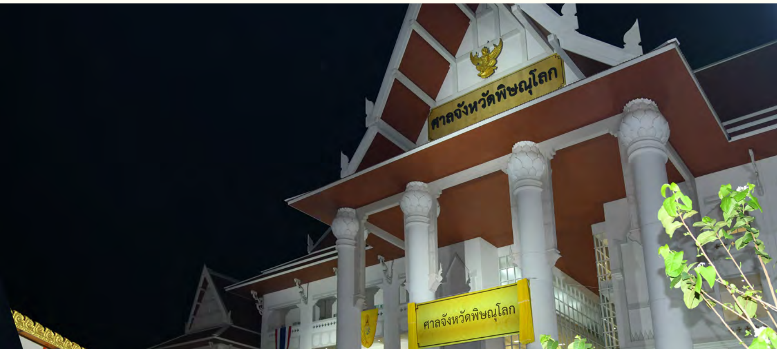
อาคารที่ทำการศาลจังหวัดพิษณุโลก
